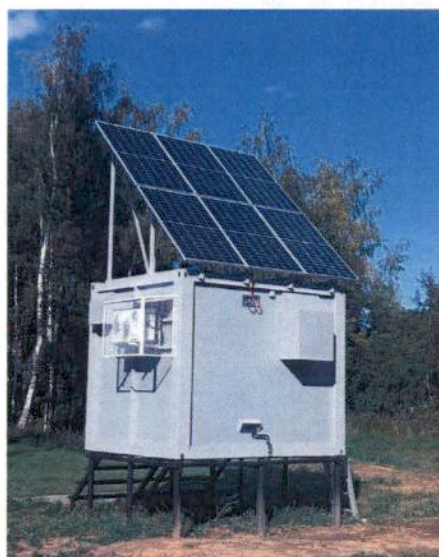
Контейнер с установленными солнечными панелями
